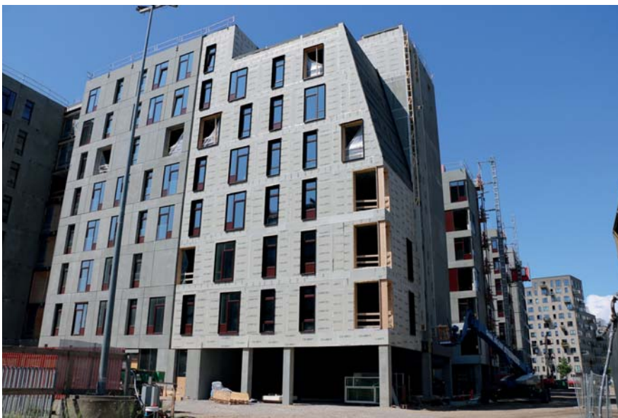
Das Generationernes Hus wird über 300 Wohneinheiten haben
